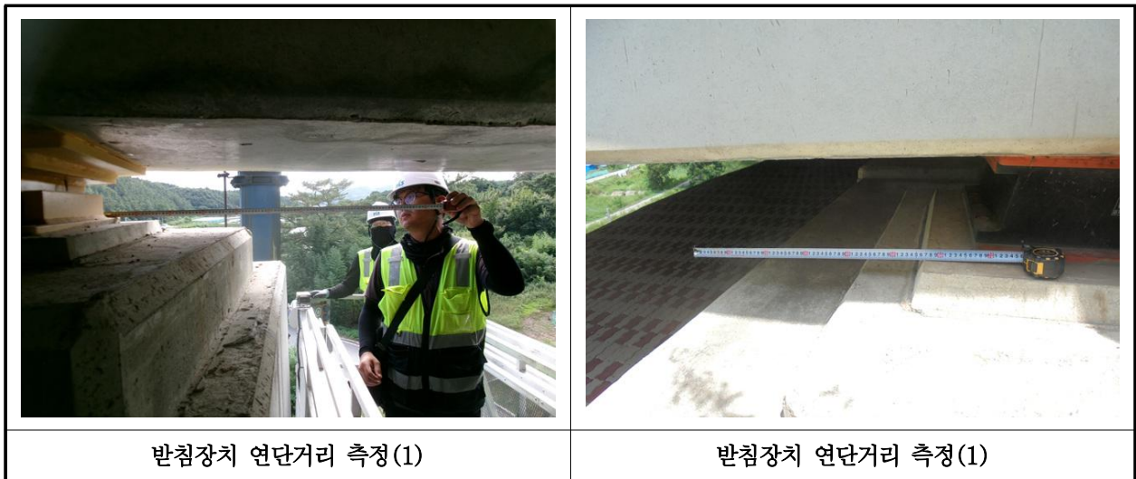
【사진 34.3.40】 교량받침장치 연단거리측정
