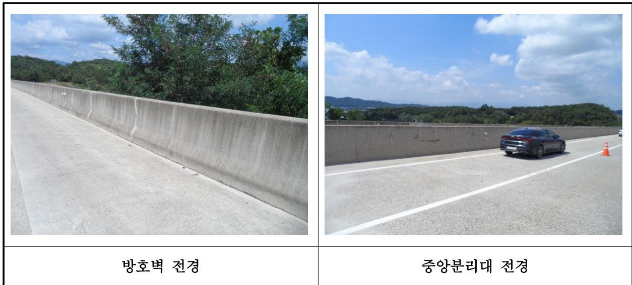
【사진 34.3.24】 방호벽 및 중앙분리대 전경
