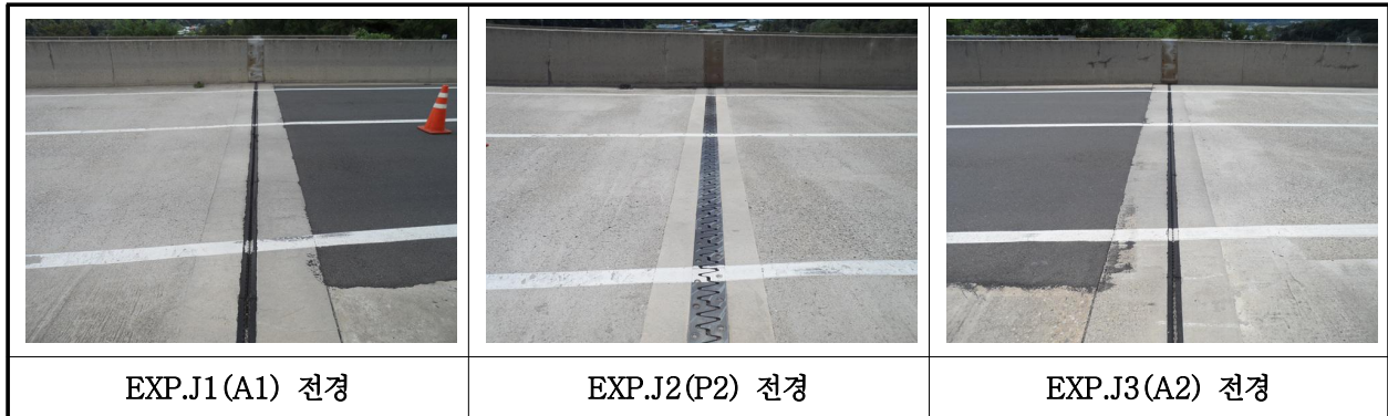
【사진 34.3.17】 신축이음장치 전경
