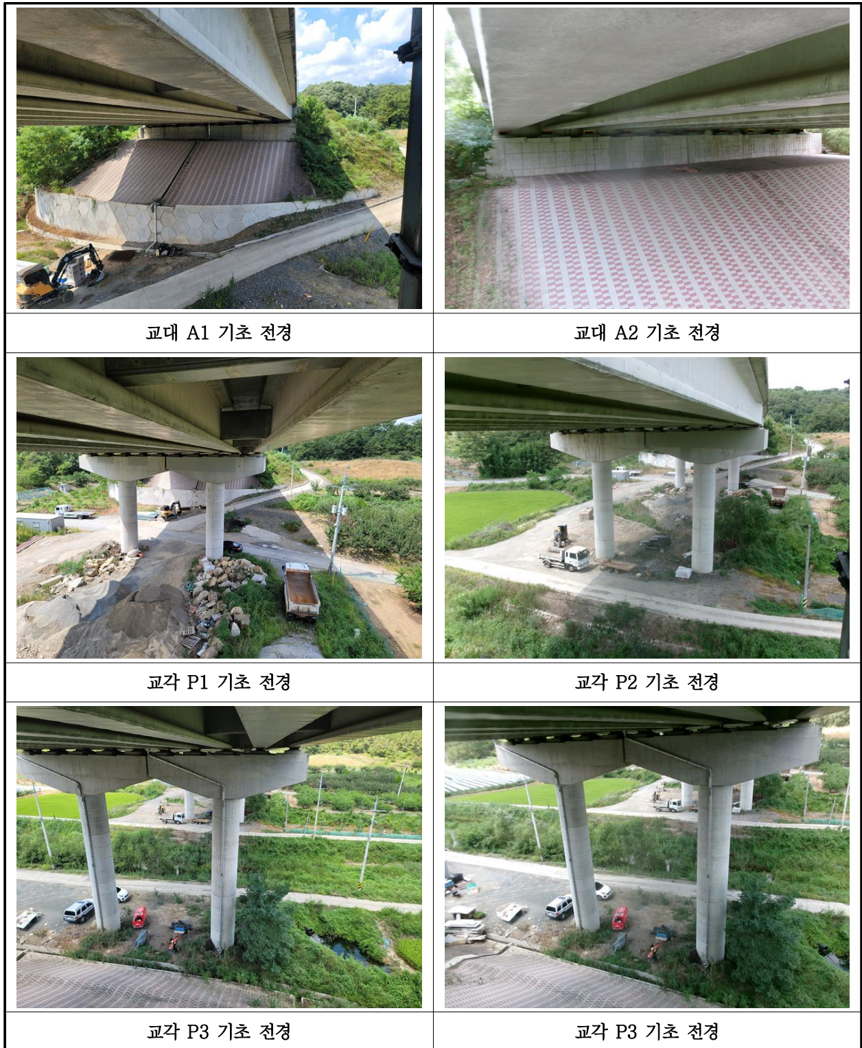
【사진 34.3.12】 기초 전경
