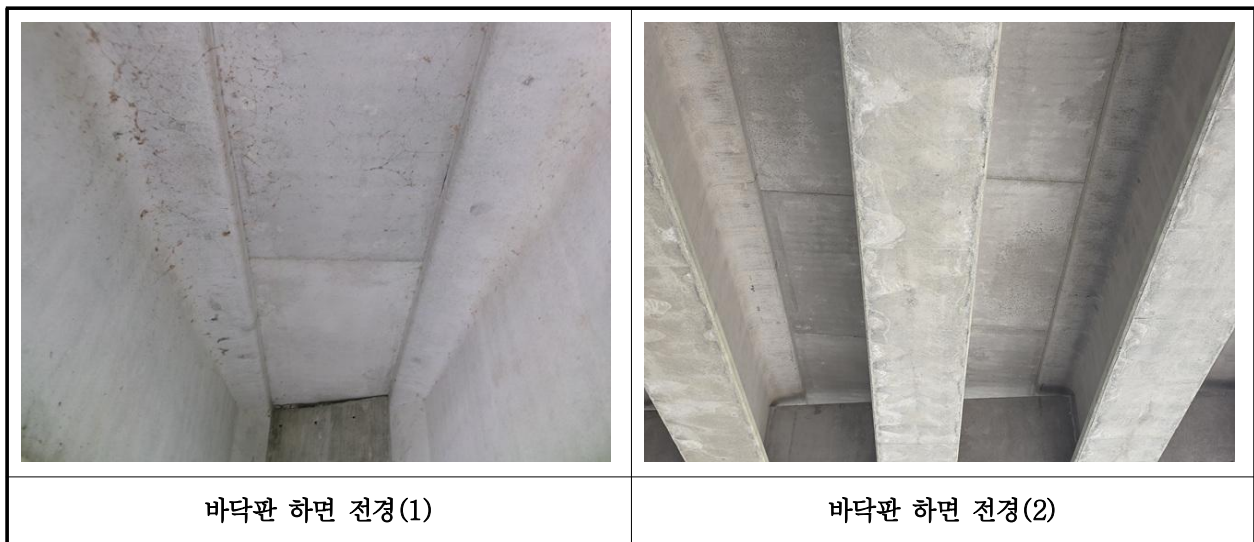
【사진 34.3.28】 바닥판하면 전경
