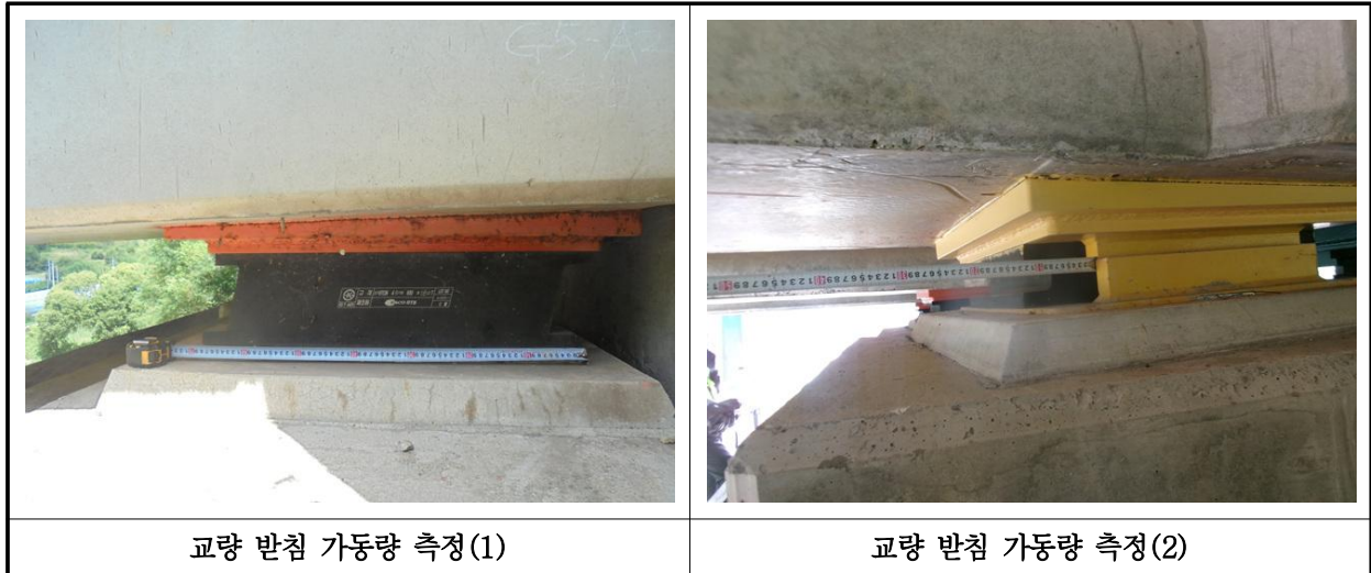
【사진 34.3.41】 교량받침 이동량 측정
