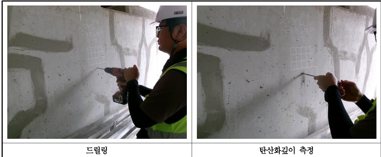
【사진 34.4.3】 탄산화 깊이 측정 현장사진
