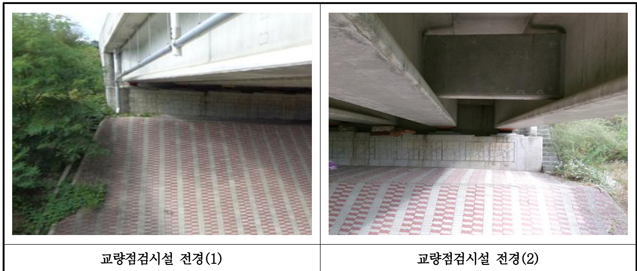
【사진 34.3.51】 교량 점검시설 전경
