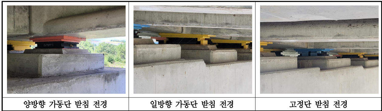
【사진 34.3.13】 교량받침 전경
