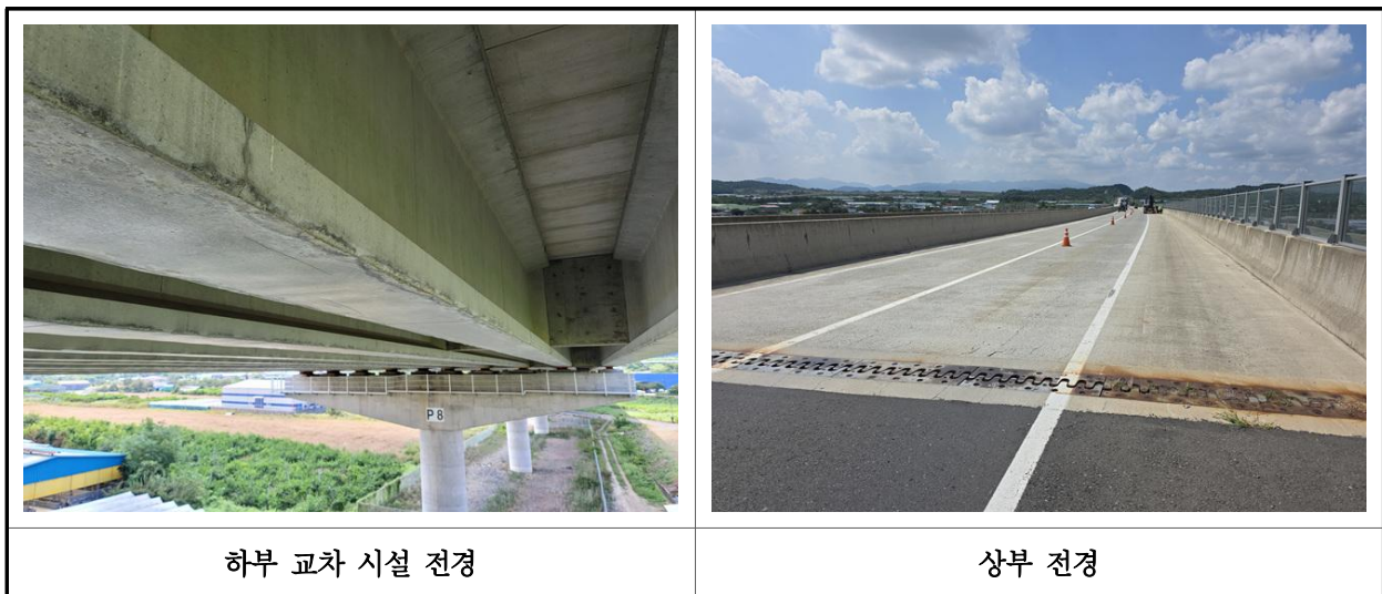
【사진 34.2.1】 부재 현장측정 전경
