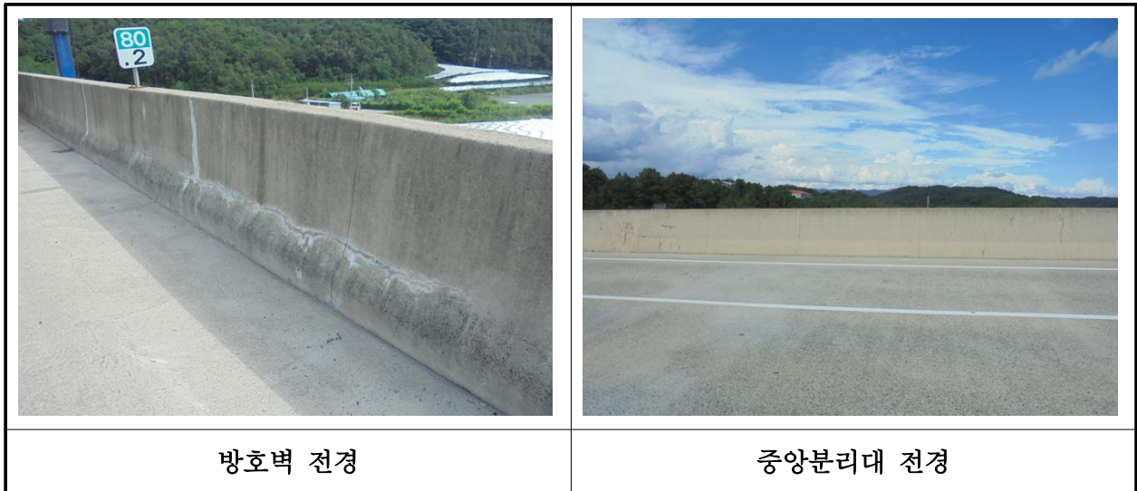
【사진 34.3.49】 방호벽 및 중앙분리대 전경
