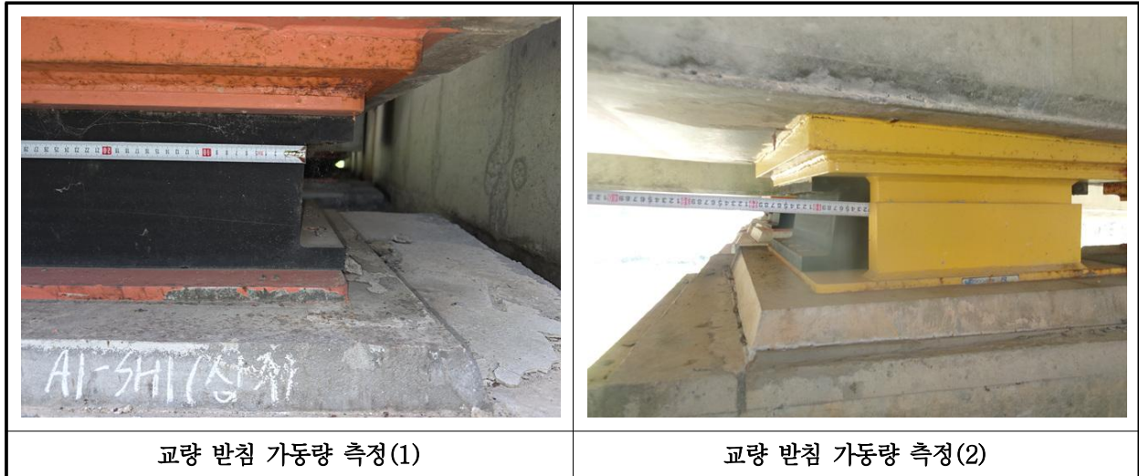
【사진 34.3.16】 교량받침 이동량 측정
