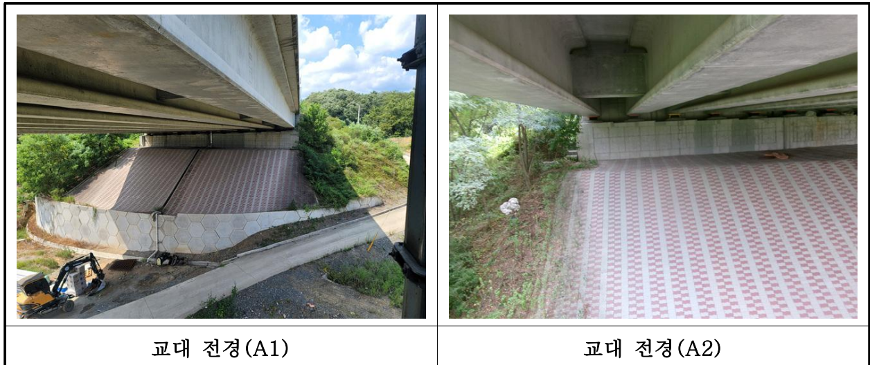
【사진 34.3.8】 교대 전경
