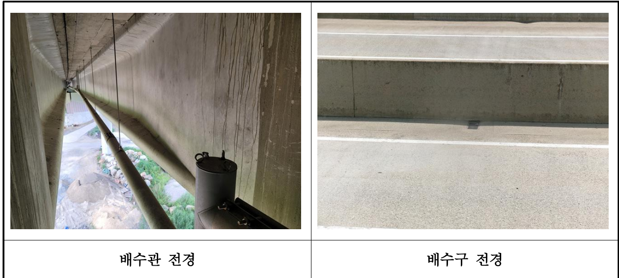
【사진 34.3.22】 배수시설 전경
