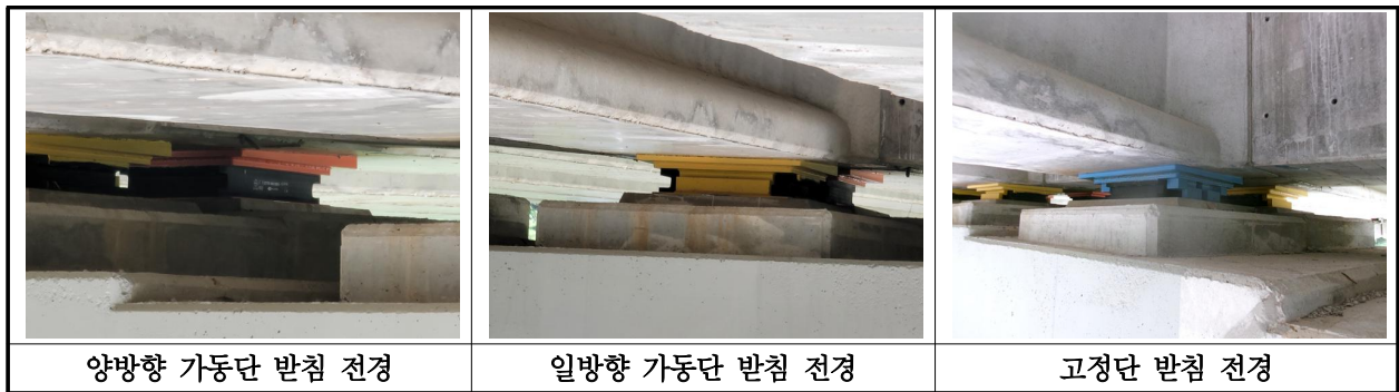
【사진 34.3.38】 교량받침 전경
