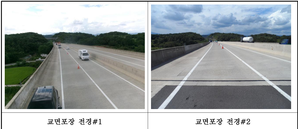
【사진 34.3.45】 교면포장 전경
