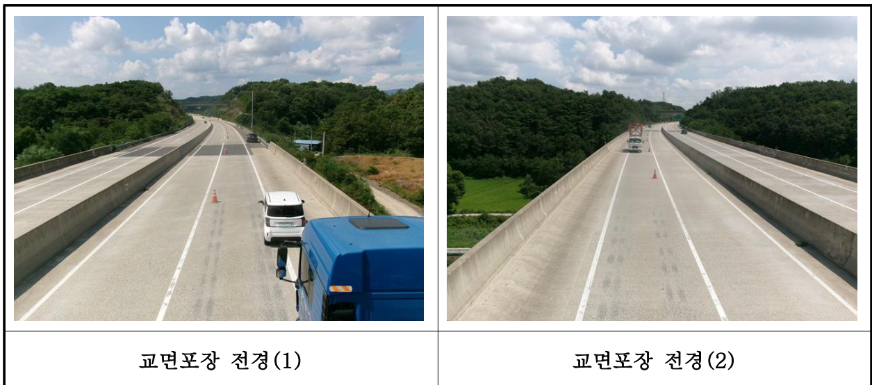
【사진 34.3.20】 교면포장 전경
