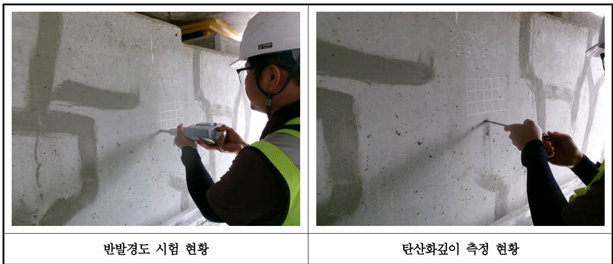
【사진 34.4.1】 콘크리트 내구성조사 현황
