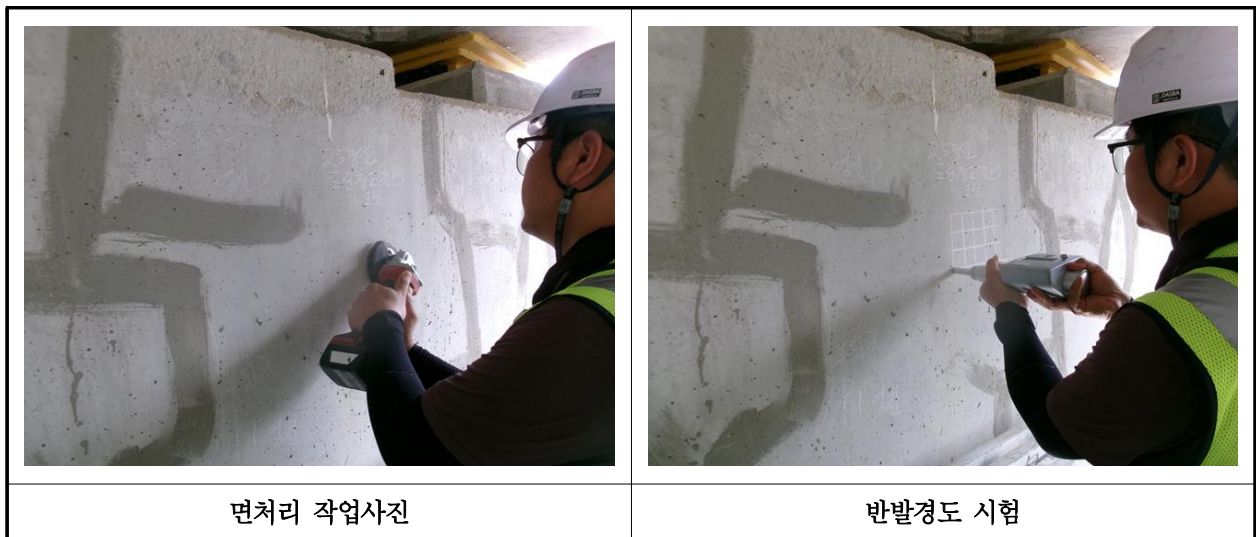
【사진 34.4.2】 반발경도시험 현장사진
